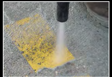
Pregătirea suprafețelor din beton
